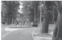
Geschwindigkeitsdämpfung im Ortseinfahrtbereich durch Mittelinsel mit deutlichem Fahrbahnversatz
