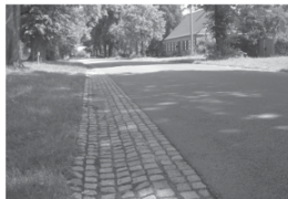
„Weiche Separation“ zwischen Fahrbahn und Seitenraum
