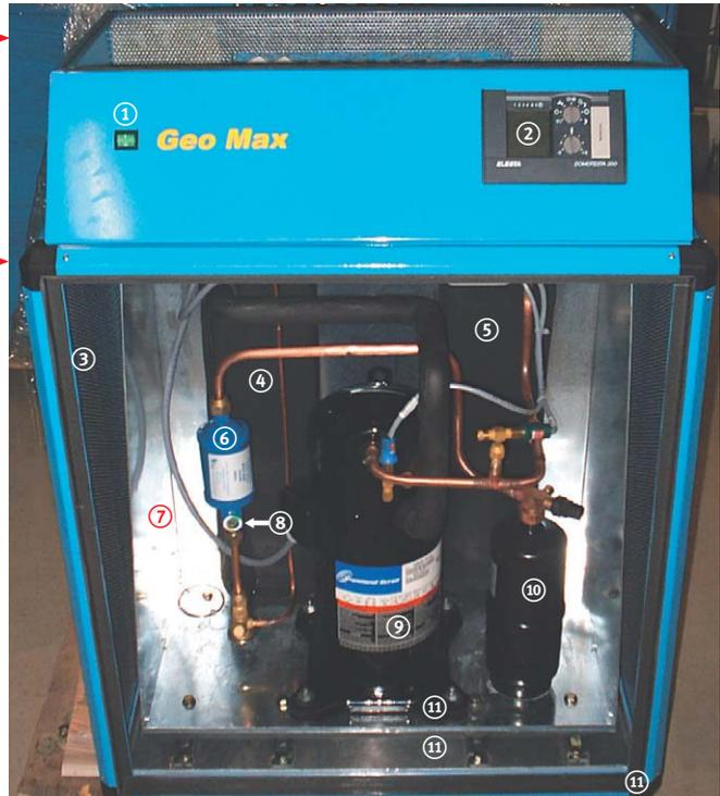
**Bild 3.13:** Kältetechnik einer Wärmepumpe
