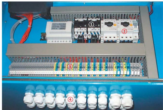
**Bild 3.14:** Elektrotechnik einer Wärmepumpe
