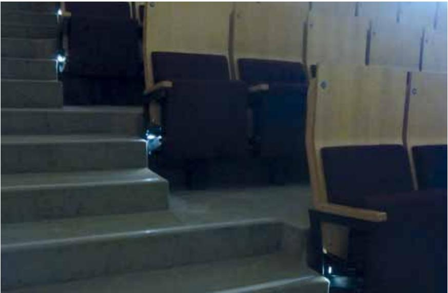
**Abbildung 5:** Die unteren Stufen mussten wegen der Verkehrssicherheit eine Beleuchtung erhalten
