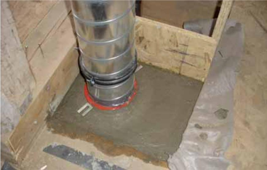
**Abbildung 3:** Für neue Nutzung notwendige Lüftungsanlage mit brandschutztechnischer Abschottung
