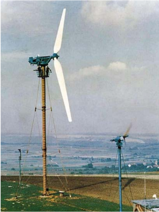
Bild 1.8 W34 Windkraftanlage (© Heiner H. Dörner)
