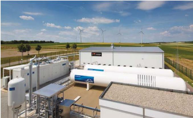
**Bild 1.1** Energiepark Mainz mit Wasserstoffspeichern: Der Wasserstoff wird mittels Elektrolyse und erneuerbarem Strom aus regionalen Wind- und Solaranlagen erzeugt (© mit freundlicher Genehmigung der Mainzer Stadtwerke AG).
