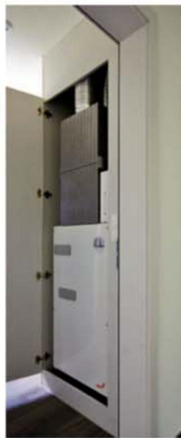
**Abb. 7.3:** Lüftungsgerät für den Schrankeinbau mit oben aufgesetzter Schalldämpferbox (Quelle: Zehnder Group AG, Gränichen, Schweiz)
