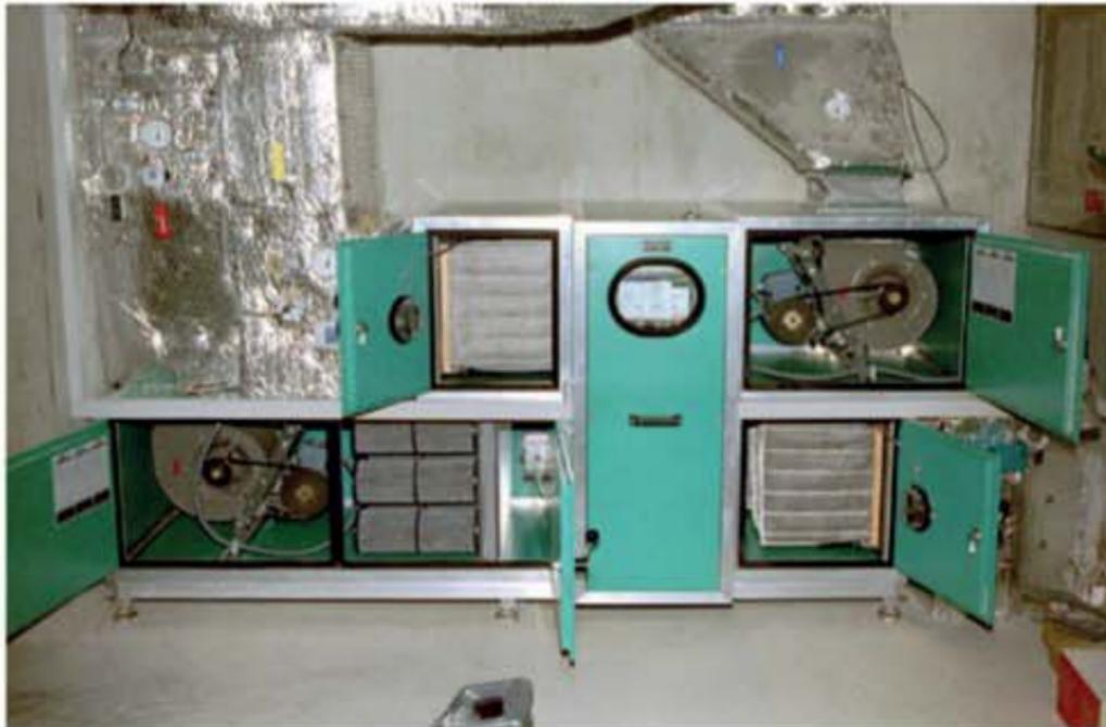
**Abb. 7.1:** Lüftungsgerät für eine Mehrwohnungsanlage mit 8 Wohnungen; wegen der Nähe einer Autobahn wurde ein Aktivkohlefilter (graue Elemente rechts vom unteren Ventilator) eingesetzt. (Quelle: Hochschule Luzern, Horw, Schweiz)
