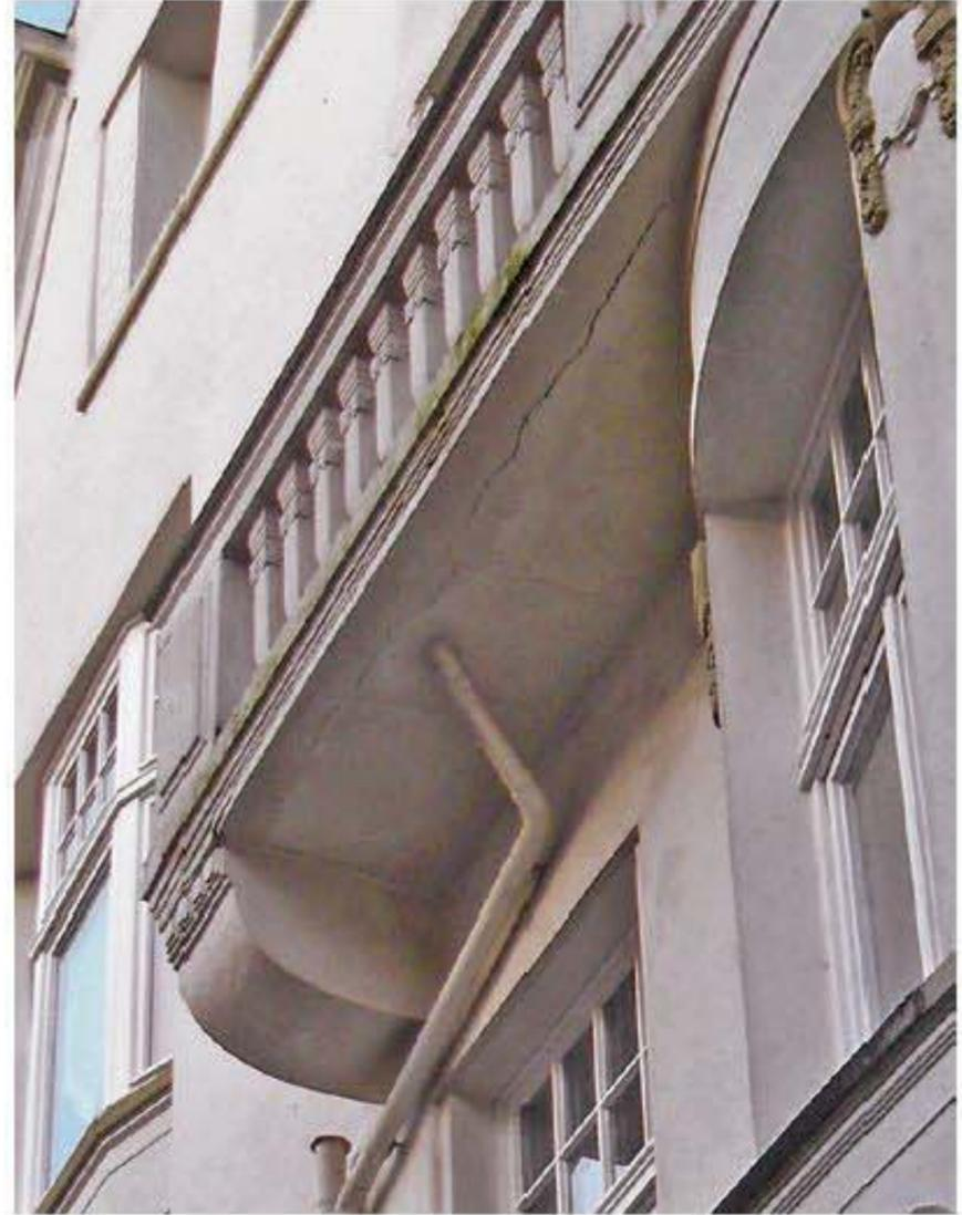
**Abb. 4.46:** Sichtbare Schäden an den Stahlträgern eines Balkons
