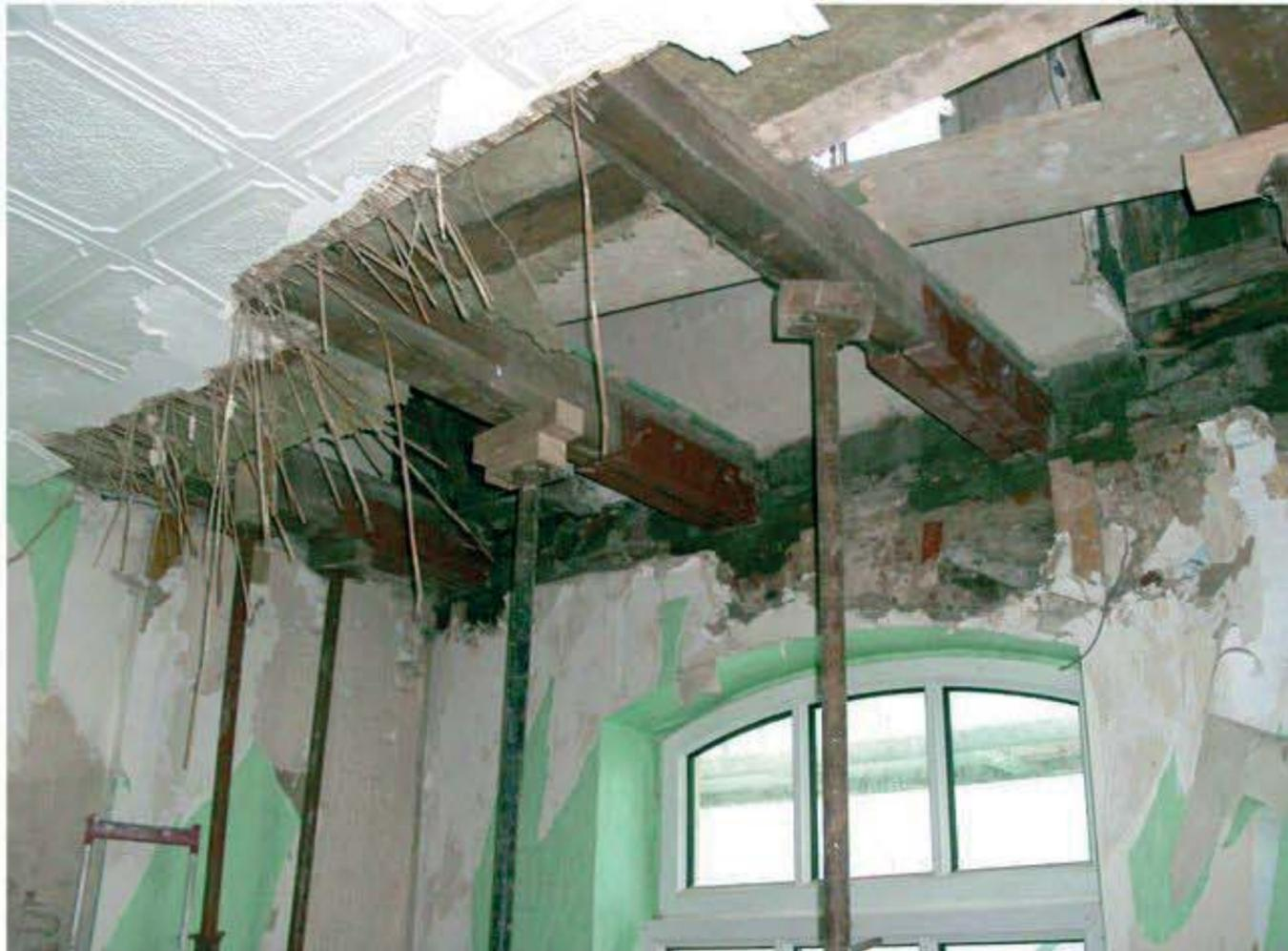
**Abb. 8.7:** Entfernter Putz, Blindboden und Fußboden und Einbau von Stahlschuhen
