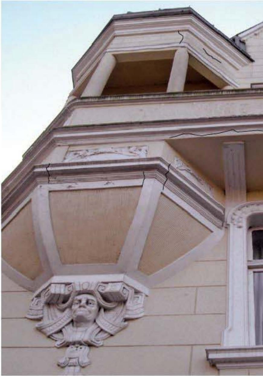
**Abb. 4.41:** Erker und Balkonkonstruktion an einem Haus der Jahrhundertwende mit Risschäden im Bereich der Eisenträger an Balkon (Unterseite vorn) und Erker (z. B. rechts)
