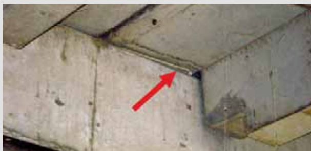
Abb. 5.4.1: Massivtrennwände: Montageausgleich
