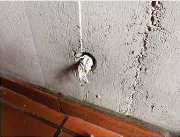
Abb. 5.4.5: Mauerstärke mit Chrysotil-asbestschnur
