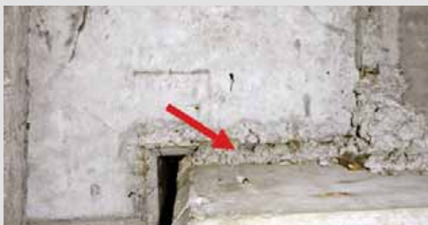
Abb. 5.4.2: Massivtrennwände: Gleitlager im Stahlbetonbau
