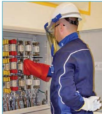
**Bild 2: Elektrofachkraft beim Ziehen eines NH-Sicherungseinsatzes**
