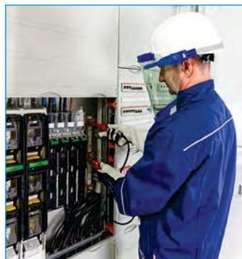
**Bild 4: Überprüfen der Spannungsfreiheit mit einem zwei-poligen Spannungsprüfer**
