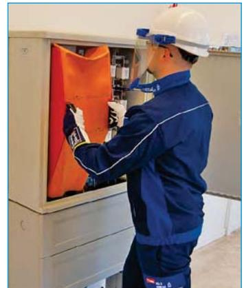
Bild 2: Abdecken spannungsführender Teile
