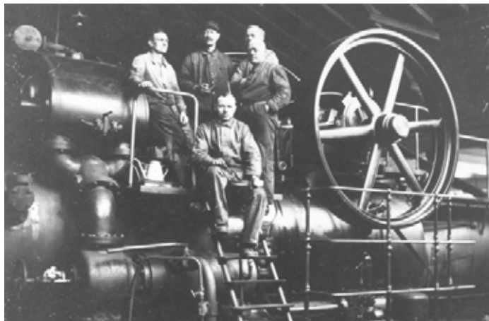
Bild 2.1 „Dampfkraftwerk Eisenach an der Rennbahn, Maschine V, 300 PS, aufgenommen 7.2.1931“
