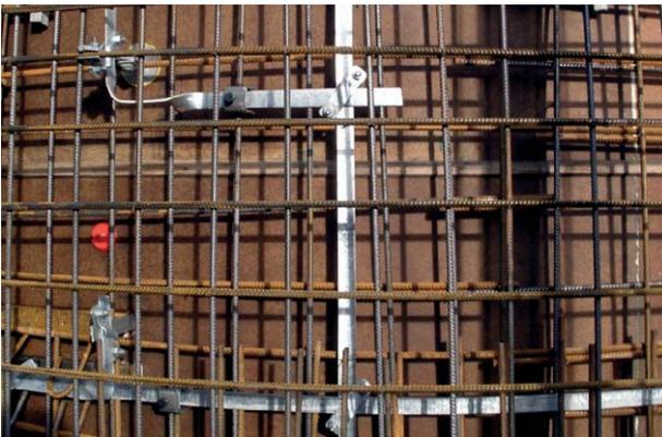
**Bild 2.1** Fundamentanker und Erdungsfestpunkt vor dem Betonieren
