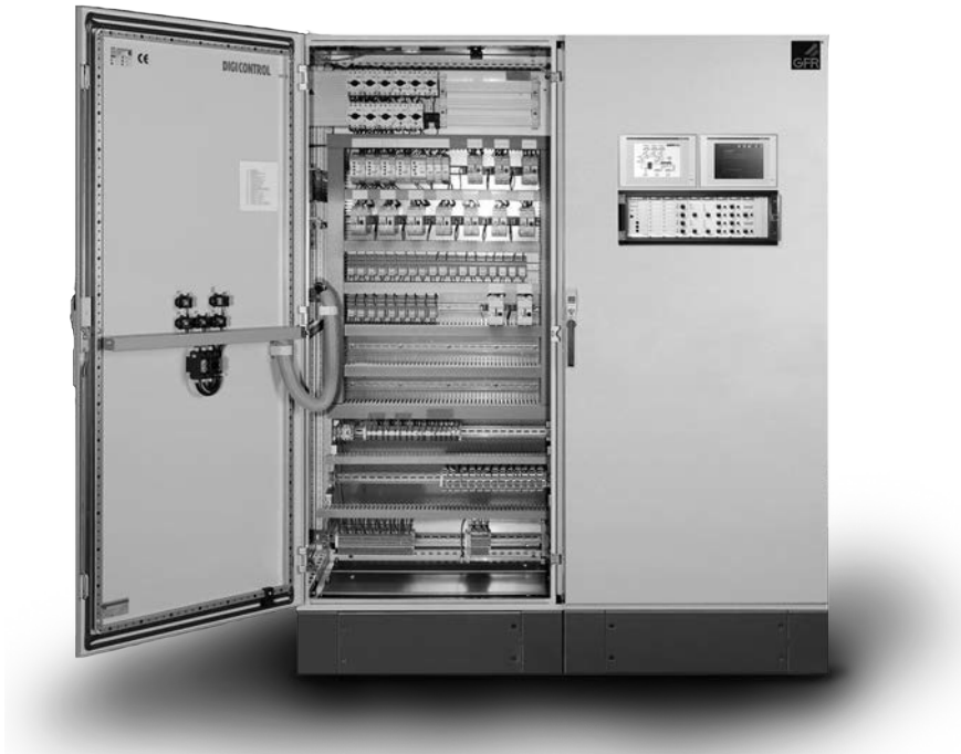
Abb. 5: Schaltschrank für Gebäudeautomation (Automationsebene), mit freundlicher Genehmigung der GFR mbH, Verl
