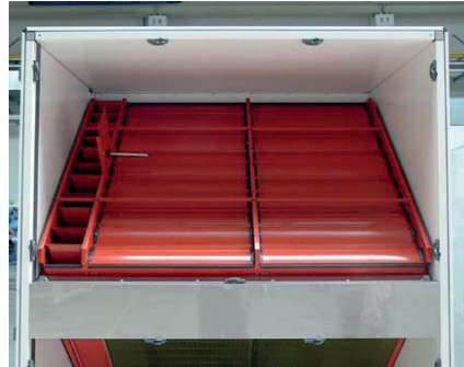
Abb. 2.11 und 2.12 Bypasslösung (jeweils links in den Abbildungen) zur Regelung der Wärmeübertragungsleistung bei einem Plattenwärmeübertrager (Quelle: M. Stahl)
