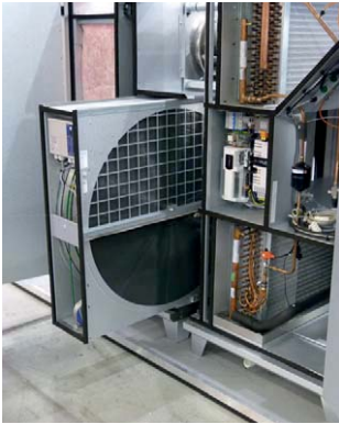
Abb. 2.13 und 2.14 Einsatz eines Rotationswärmeübertragers in einem RLT-Gerät (links) und rechts ein Detail der Rotorwicklung aus dünnen glatten und gewellten Aluminiumfolien/-blechen (Quelle: M. Stahl)
