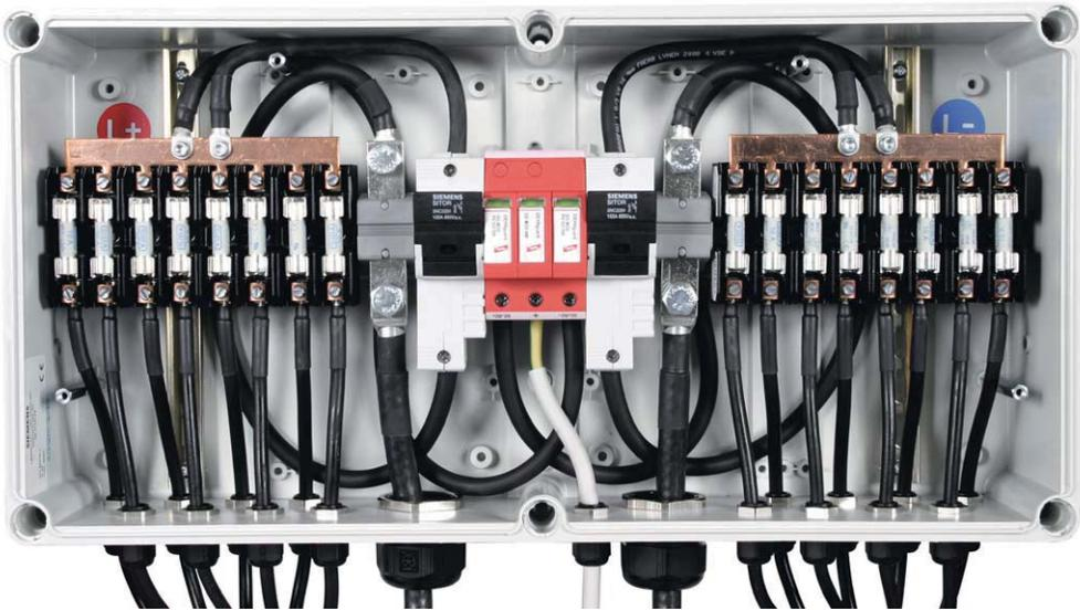
**Abb. 4.3:** Anordnung von Überspannungsschutzschaltern im Generatoranschlusskasten eines Solargenerators. Die Schutzschalter sichern die Generatorhauptleitung (DC) gegen Überspannung, bevor sie ins Gebäude geführt und an den DC-Eingang des Wechselrichters angeschlossen wird. (Foto: Dehn + Söhne, Neumarkt)
