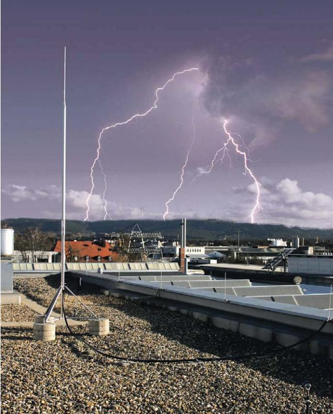
**Abb. 4.2:** Fangstangen und ausreichender Blitzschutz sind ein Muss in der Photovoltaik, auch bei kleineren Anlagen. Denn niemand kann vorhersehen, wann und wo ein Blitz einschlägt. Die Folgen können verheerend sein. (Foto: Dehn + Söhne, Neumarkt)
