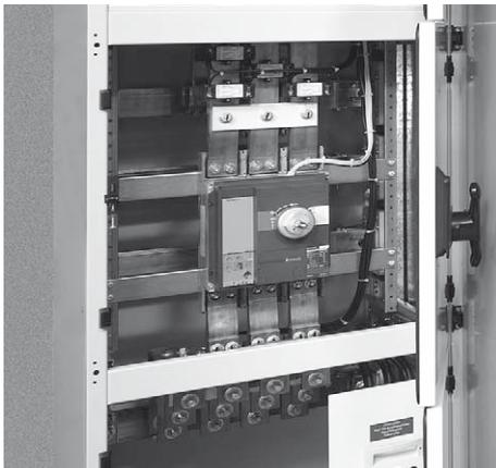
**Bild 8.6.3-1** Beispiel für Verdrahtung mit blanken Leitern
