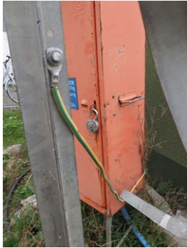
Bild 704.2 Anschluss einer Erdungsleitung an einen Staberder auf der Baustelle (Foto: Rolf Rüdiger Cichowski)
