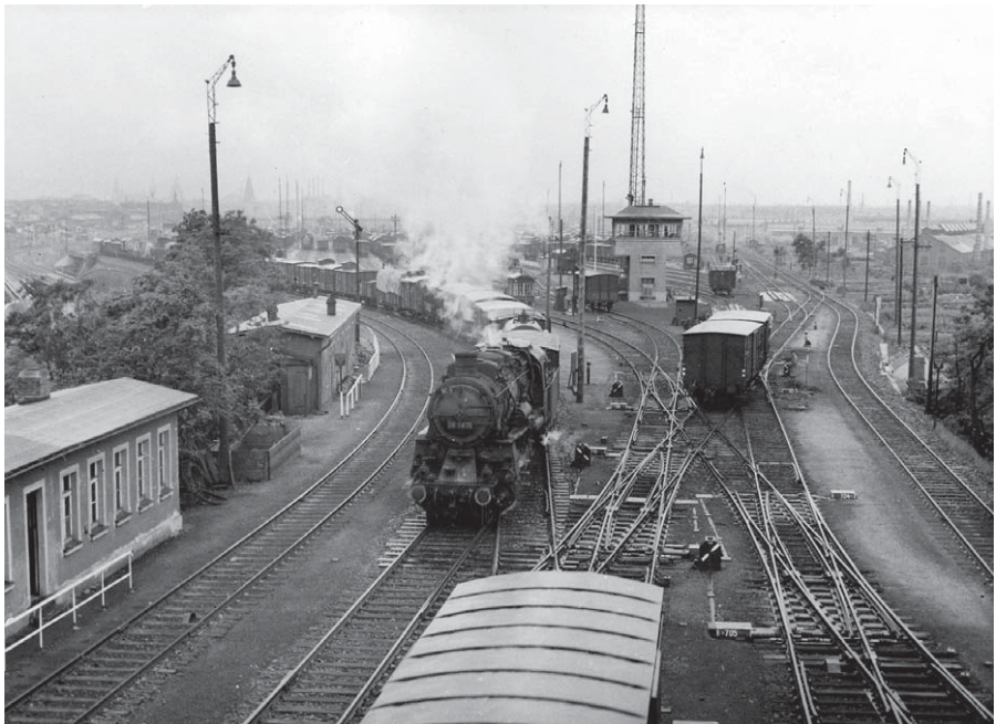
Bild 9.9 Gesamtansicht Bahnhof Dresden-Friedrichstadt vom Stellwerk 20 mit Flutlichtmast – Tagaufnahme
