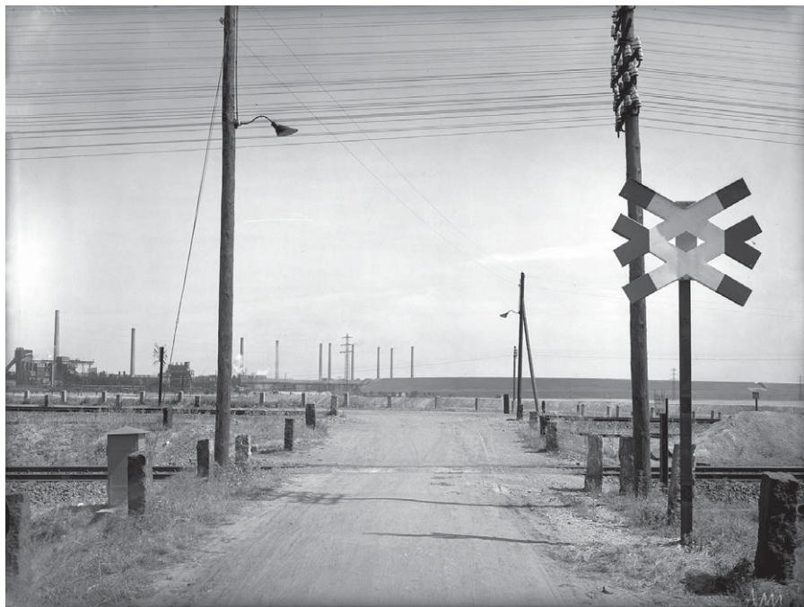
Bild 9.5 Schirmleuchte zur Beleuchtung von Bahnübergängen; unbeschränkter Wegübergang einer dreigleisigen Nebenbahn
