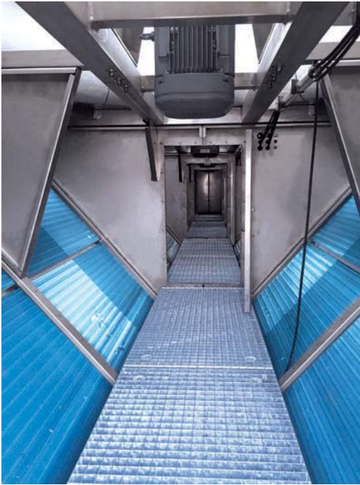
Bild 5.2: Optimierte Zugänglichkeit reduziert die Wartungszeiten und erlaubt aussagefähige Inspektionsergebnisse (Bild: Gohl)
