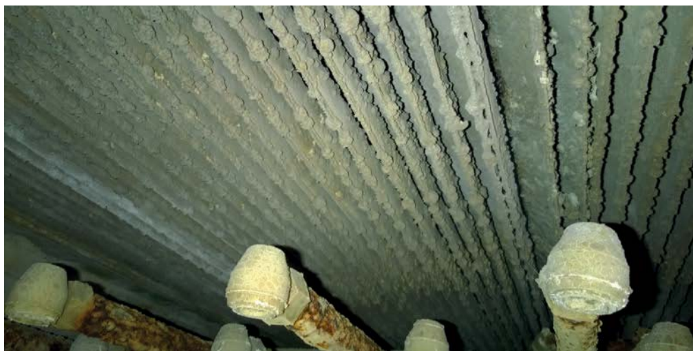
Bild 5.4: Die Wirkung von Tropfenabscheidern hängt maßgeblich auch vom Wartungszustand ab (Bild: DMT)
