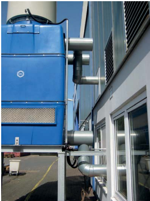
Bild 5.1: Die eingeschränkte Zugänglichkeit von VKA erhöht das Hygienierisiko (Bild: DMT).
