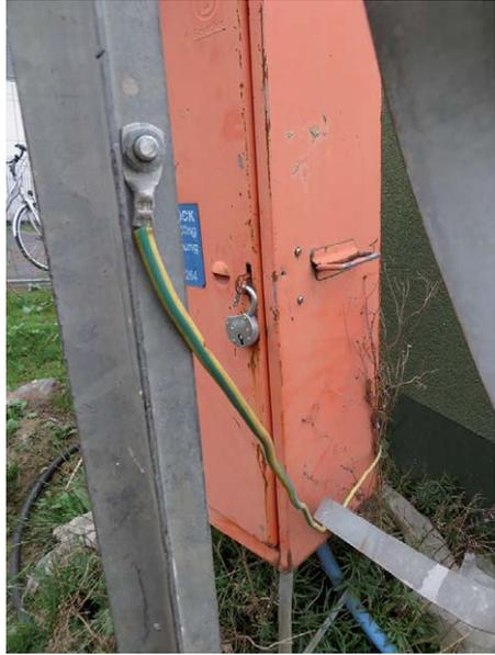
**Bild 704.4** Anschluss einer Erdungsleitung
