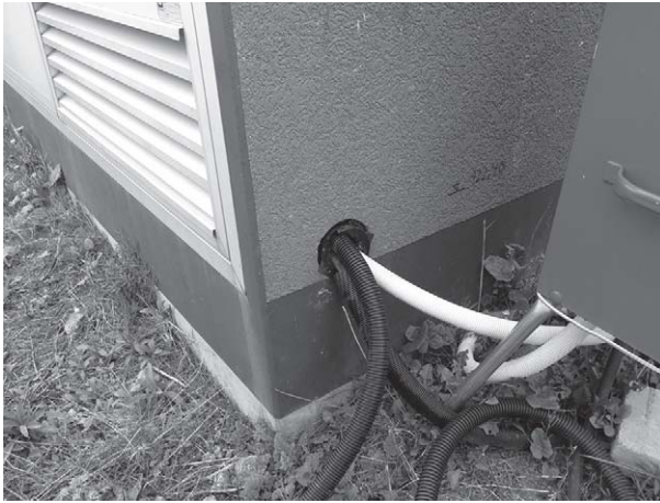
Bild 6.3 Anschluss eines Baustromverteilers an eine 10-kV-Station (Foto: Rolf Rüdiger Cichowski)
