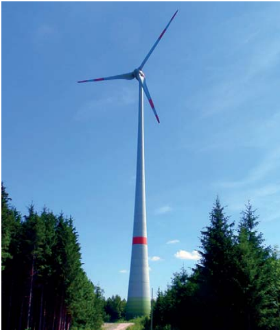
Bild 4.38 Fertigteil-Betonturm (Enercon E-82, Bemessungsleistung 2,3 MW, Nabenhöhe 138 m, Inbetriebnahme 2012) am Windstützpunkt Wildpoldsried (Bayern)
