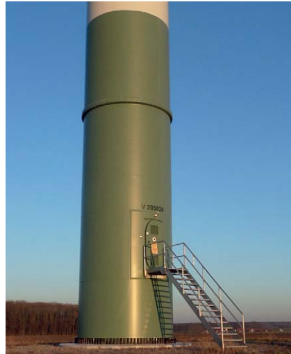
Bild 4.37 Stahlrohrturm (Vestas V112-3.0 MW)
