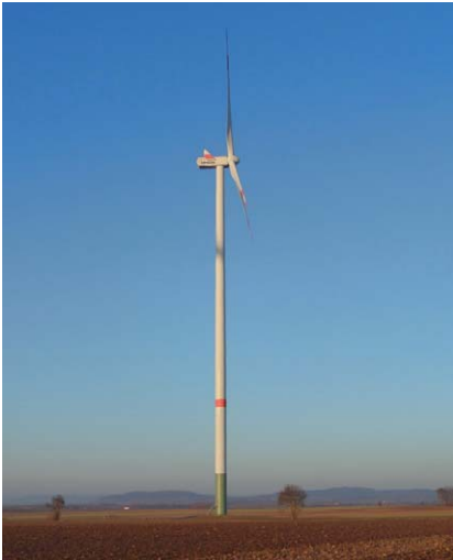
Bild 4.36 Stahlrohrturm (Vestas V112-3.0 MW, Bemessungsleistung 3 MW, Nabenhöhe 140 m) am Windstützpunkt Uffenheim (Bayern)
