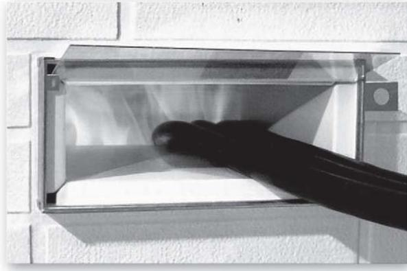
**Bild 3.9** Brandschott mit speziellem Systemrahmen
