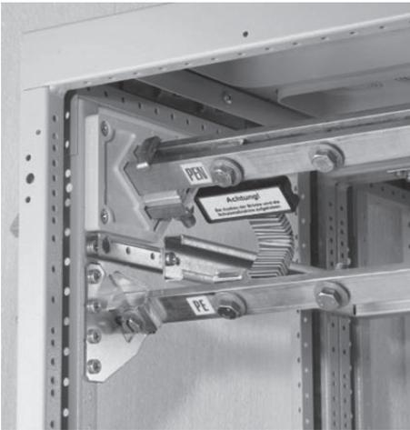
**Bild 8.4.3.2.3-7** Beispiel einer Ausführung für den zentralen Erdungspunkt
