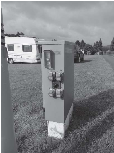
Bild 9.2 Verteiler auf dem Campingplatz für vier Stellplätze Foto: Rolf Rüdiger Cichowski , Holzwickede
