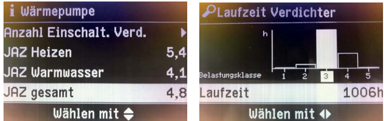
Abb. 1.18: Wärmepumpenregler Vitocal 300, Fabrikat Viessmann (Fotos: Hans-Jürgen Seifert)
