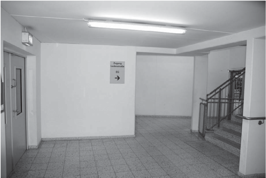
Bild 2.71 Beleuchtetes Sicherheitszeichen an der Tür im Zug des Rettungswegs in der Verkaufsstätte
