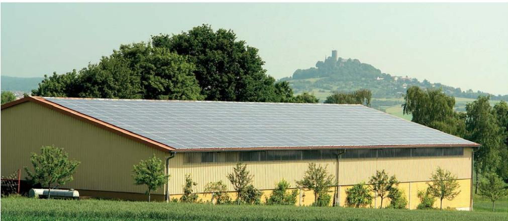
**Abb. 1.4:** Wenn der Generator wie hier das ganze Dach bedeckt, wird es schwierig mit der Wartung der Anlage. Im Zweifelsfall muss der Handwerker sich einen Weg bahnen, indem er Module deinstalliert, damit er an ein Panel in der Mitte der Anlage herankommt.
