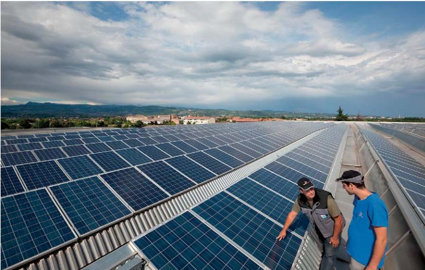
**Abb. 6.1:** Bei diesem großen Dachgenerator in Italien wurden die alten, leistungsschwachen Solarmodule gegen leistungstärkere Module ausgetauscht – ein klassisches Beispiel für das Repowering von Solarmodulen. (Foto: Fronius International GmbH)
