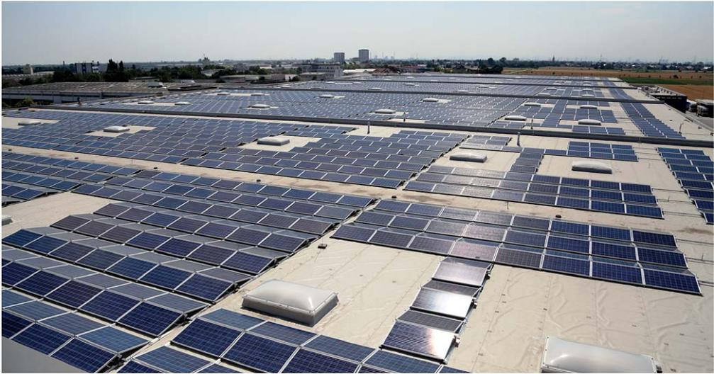
**Abb. 1.5:** Bei dieser Anlage wurde an die Instandhaltung gedacht. Es gibt genügend Platz zwischen den Modulreihen, damit ein Servicetechniker jedes Panel erreicht. Viele Hersteller von Montagegestellen haben die Abstände bereits in ihre Systeme integriert. (Foto: Wircon GmbH)
