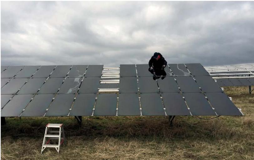
**Abb. 6.2:** Bei Solarparks bietet sich das Repowering an, wenn beispielsweise ältere Dünnschichtmodule gegen kristalline Solarmodule getauscht werden. (Foto: Adler Solar)
