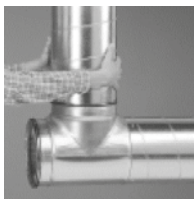
Bild 7.3: Montage eines T-Stück-Abzweigs mit Stecklippendichtung (Werkbilder: Lindab GmbH)
