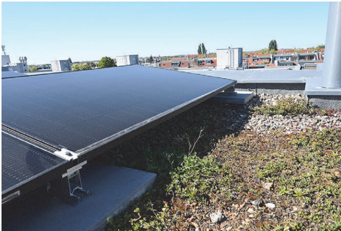
Abb. 1.40: Die Module schweben zwar flach über dem Gründach. Doch das Sedum besteht hauptsächlich aus flach wachsenden Pflanzen. Dennoch muss der Handwerker bei der Wartung genau prüfen, ob sich nicht doch hochwachsende Pflanzen angesiedelt haben. (Foto: Velka Botička)
