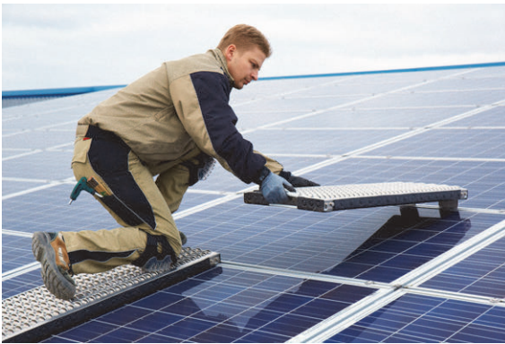
Abb. 1.6: Um dennoch über Module klettern zu können, ohne dass sie Schaden nehmen, hat SMB ein Multiboard entwickelt, das der Handwerker auf das Paneel legt. Es funktioniert aber nur bis zu einer begrenzten Dachneigung. (Foto: SMB Solar Multiboard)
