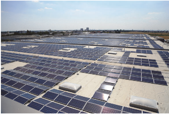
Abb. 1.5: Bei dieser Anlage wurde an die Instandhaltung gedacht. Es gibt genügend Platz zwischen den Modulreihen, damit ein Servicetechniker jedes Paneel erreicht. Viele Hersteller von Montagegestellen haben die Abstände bereits in ihre Systeme integriert. (Foto: Wircon GmbH)
