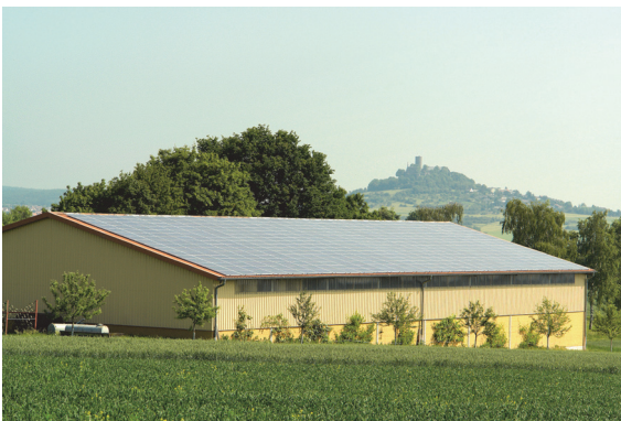
Abb. 1.4: Wenn der Generator wie hier das ganze Dach bedeckt, wird es schwierig mit der Wartung der Anlage. Im Zweifelsfall muss der Handwerker sich einen Weg bahnen, indem er Module deinstalliert, damit er an ein Panel in der Mitte der Anlage herankommt. (Foto: Wagner Solar GmbH)
