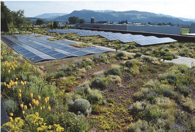
Abb. 1.39: Die Wartung eines solaren Gründachs entscheidet sich schon in der Planung. Ist der Abstand der Module vom Substrat zu gering, ist mehr Aufwand notwendig. (Foto: Bundesverband Gebäude-Grün)
