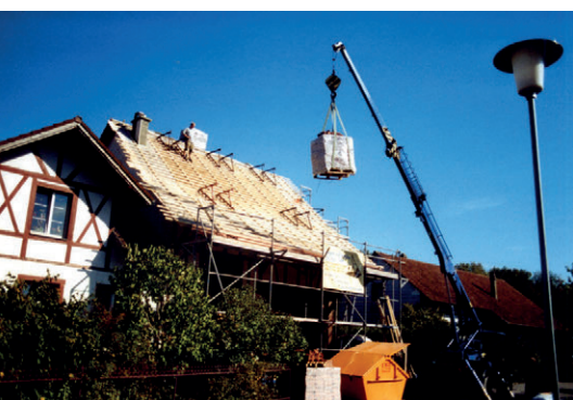
Vor der Neubelastung von Dächern müssen alle notwendigen Verstärkungen ausgeführt sein [A].
