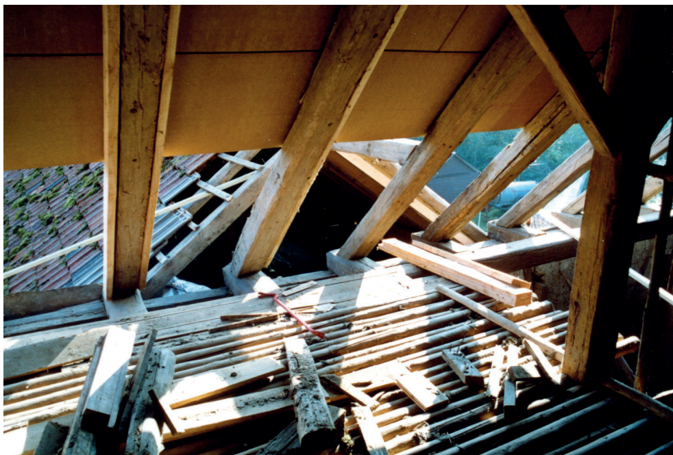
Seitliche Bohlenbretter verstärken schwache Dachsparren [A].
