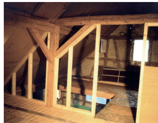
Wachspapier auf der Dachinnen-seite reduziert den Kondensateintrag in die Konstruktion, ohne Feuchtigkeiten einzuschließen [A].
