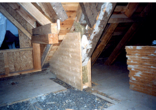
Wichtige lastabtragende Fußpunkte können mit Dreischichtplatten gesichert werden. Schadhafte, aber erhaltensfähige Bauteile können so auch überbrückt werden. Die statischen Maßnahmen sind zusammen mit einem Statiker anzuordnen und abzunehmen [B1].
