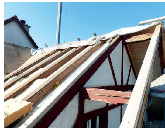
Verstärkungen der Dachsparren erlauben einen Flächenausgleich von Unebenheiten und eine verbesserte Wärmedämmung (sommerlicher und winterlicher Wärmeschutz) [A].
