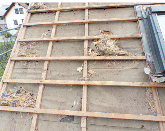
In Hohlräumen alter Dächer finden sich häufig Tiernester und Beschädigungen der Dichtungsebenen [A].
