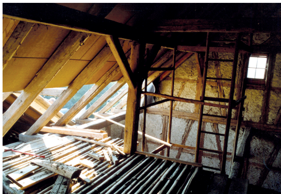
Diffusionsoffene Unterdachebenen ermöglichen ein Austrocknen von Feuchtigkeiten in der Konstruktion [A].
