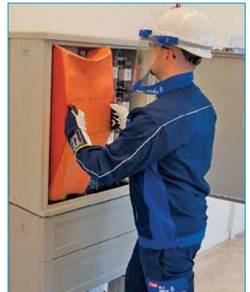
**Bild 2: Abdecken spannungsführender Teile**
