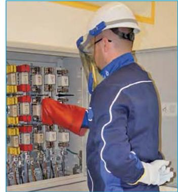
**Bild 2: Elektrofachkraft beim Ziehen eines NH-Sicherungseinsatzes**
