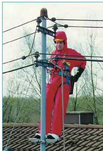
**Bild 3: Elektrofachkraft mit isolierendem Schutzanzug**
