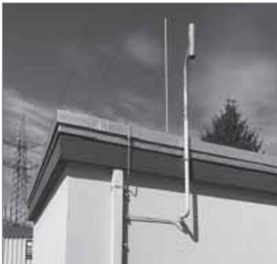
**Bild 11.1** Blitzschutz/Fangeinrichtung an Gas-Druck-Regelanlagen
