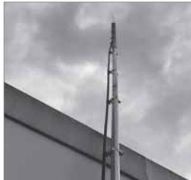
**Bild 11.2** Blitzschutz/Fangeinrichtung an Gas-Druck-Regelanlagen
