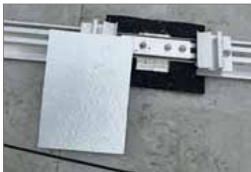
Bild 2.6 Unterlegmatte mit Alufolie zur Vermeidung von Weichmacherwanderung
