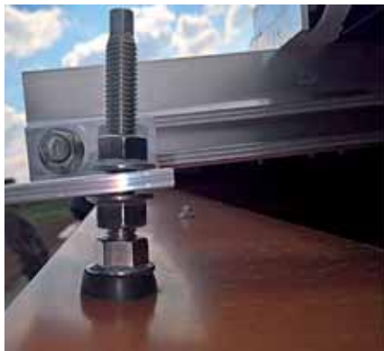
Bild 2.7 Nicht fachgerecht befestigte Stockschraube
