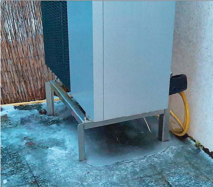
Abbildung 2.9 Vereister Boden rund um eine Luftwärmepumpe
