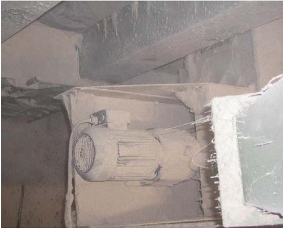
Abb. 10.5.4.4-1: Motor mit unzulässiger Staubbelastung (Mühlbetrieb), Quelle: VGH Versicherungen
