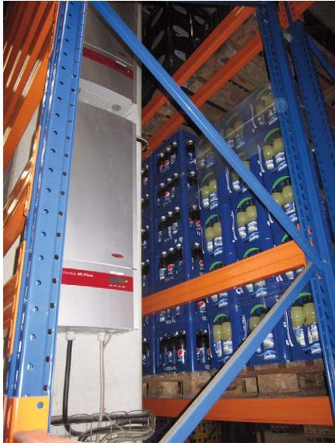
Abb. 10.5.4.1-1: PV-Wechselrichter in einem Lager für PET-Flaschen in Kunststoffkisten, Quelle: VGH Versicherungen
