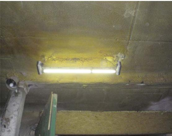
Abb. 10.5.4.3-2: Leuchten mit brennbarem Dämmmaterial „eingeschäumt“, Quelle: VGH Versicherungen
