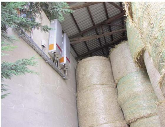
Abb. 10.5.4.1-2: PV-Wechselrichter in einem Strohlager, Quelle: VGH Versicherungen
