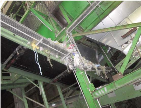
Abb. 10.5.4.2-1: Ablagerung von Kunststoffabfällen auf einer Kabelbühne, Quelle: VGH Versicherungen
