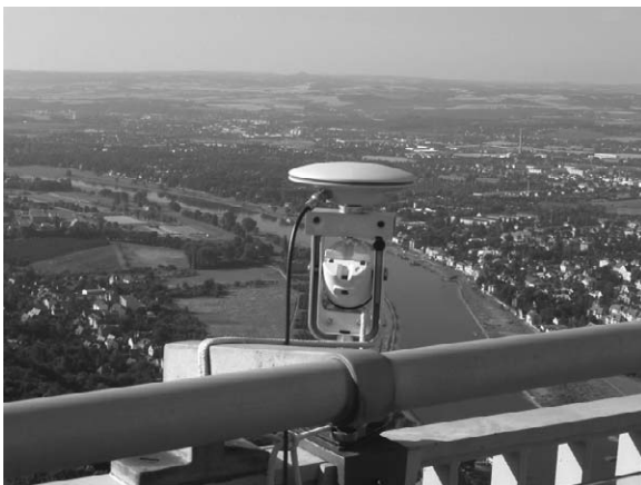
Abb. 1.5: Reflektor und GNSS-Antenne zur Turmüberwachung
