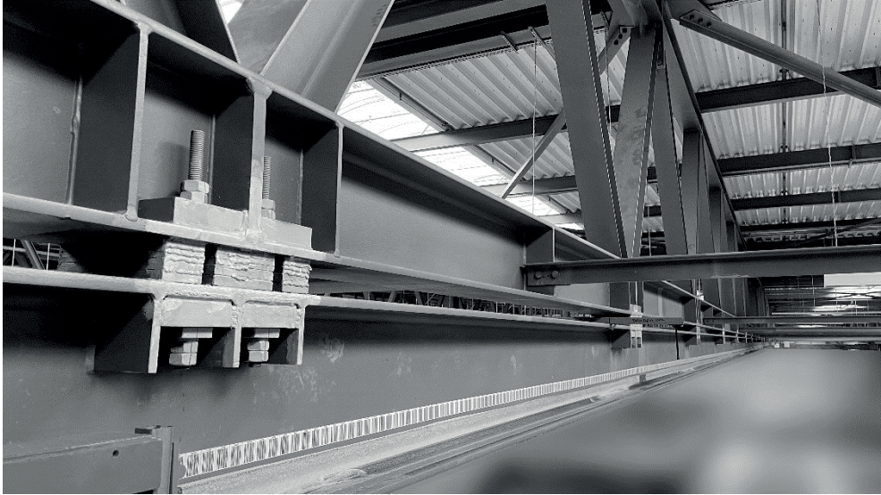
Abb. 5: Dachstruktur mit Fachwerkträger und darunter befindlichem Kranbahnbalcken
