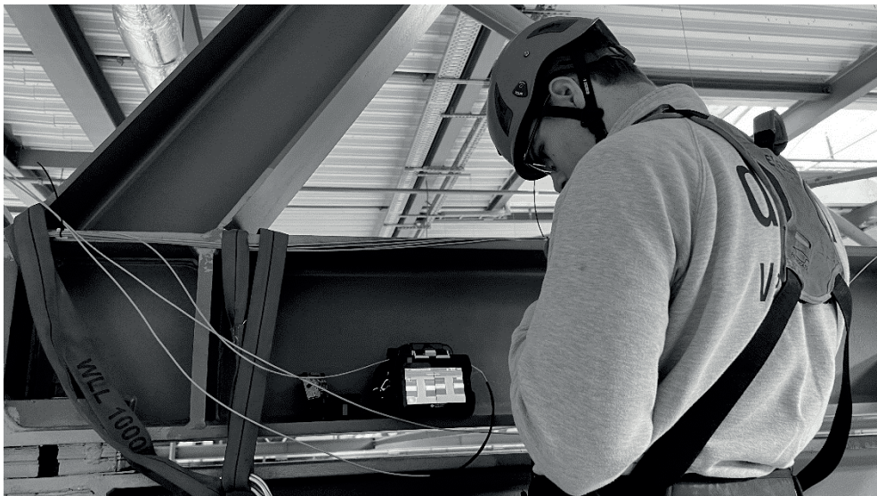
Abb. 8: Splicen der Zuleitung zum Sensor in der Dachstruktur
