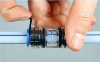
3. Ziehen des Sicherungsclips;
